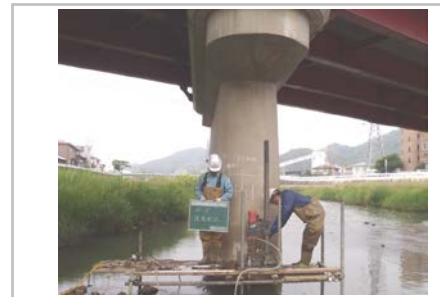
ボーリングによる橋脚形状把握事例
