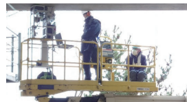
橋梁点検車による計測状況
