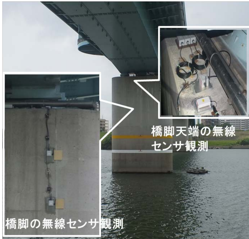
久留米大橋(国道3号)
