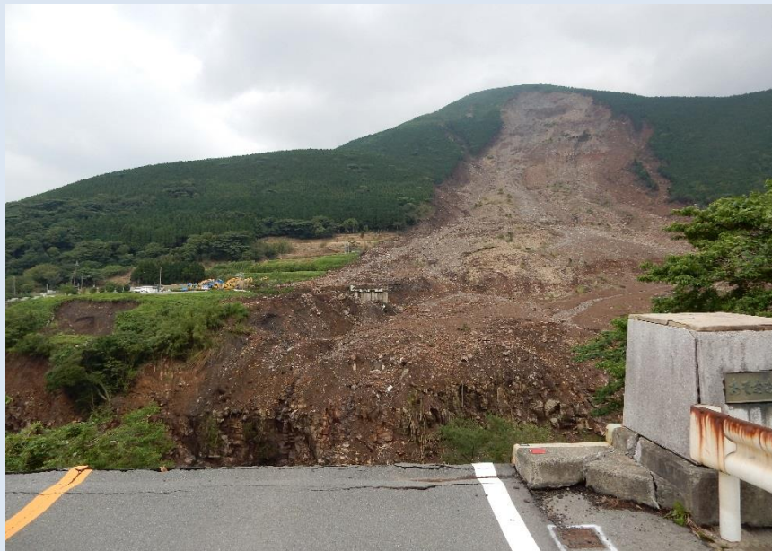
▲斜面崩壊状況の撮影状況
